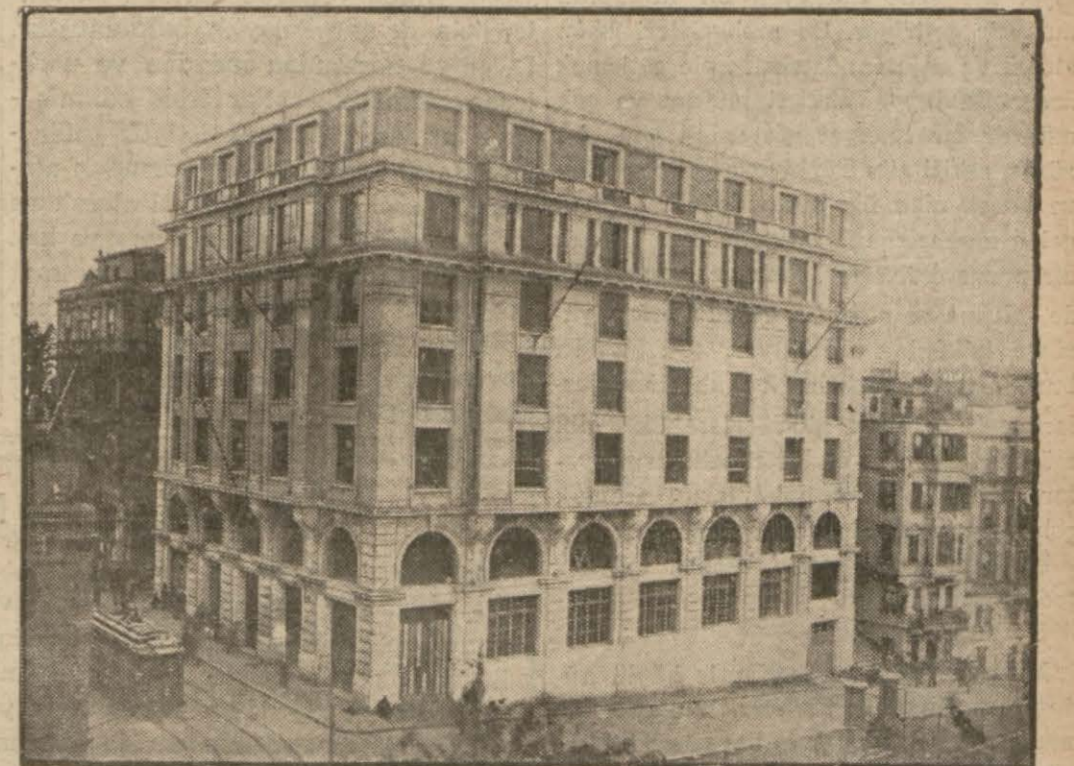
Elektrik idaresi binası
